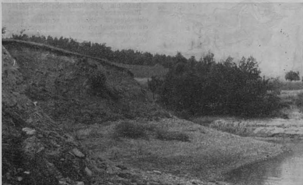
Zbyszyce — dewastacja brzegów
