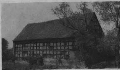
Fot. 6. Kantorowice, spichlerz XVIII w. Bryła jest tu prosta (dwukondygnacyjny prostokąt nakryty dachem dwuspadowym) i prosta konstrukcja: regularna kratownica wypełniona drobnymi drewniakami, tworzącymi jak gdyby płotki oklejone gliną. Oszczędna i nietrwala konstrukcja. Spichlerz kantorowicki należy do ciekawszych zabytków, gdyż jest to największy obiekt tak właśnie zbudowany, który zachował się na Śląsku Opolskim.
