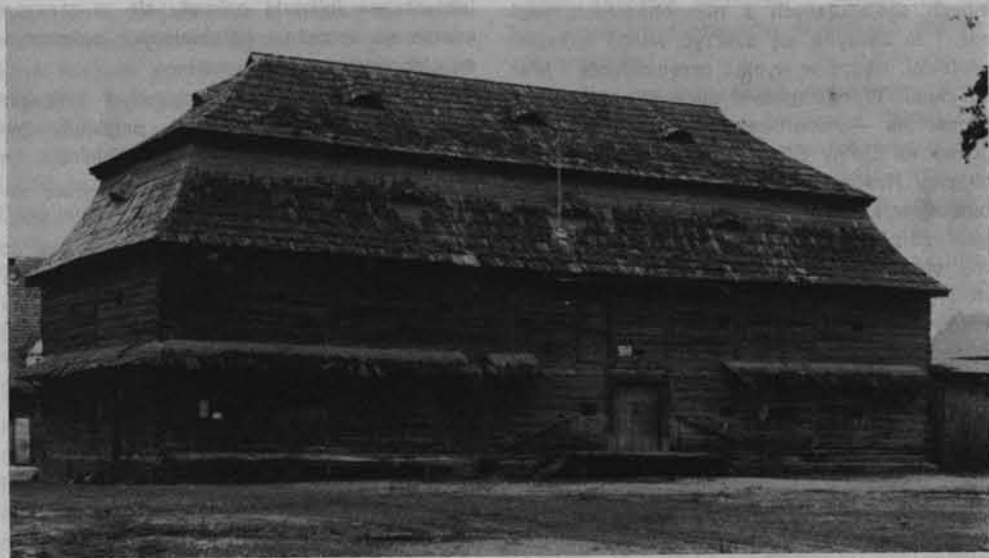
Fot. 3. Sławięcice, spichlerz dworski. Dachy, występujące niemal z reguły, miały wyraźnie użytkowe uzasadnienie: osłaniały otwory okienne (oczywiście nigdy nie oszklone, a spełniające dodatkowo rolę wywietrzników) przed ostro zacinającymi deszczami. Względ na użyteczność idealnie zespolił się z czynnikiem estetycznym: jakże bowiem owe daszki dodają lekkości i wytworności masywnym i właściwie ciężkim bryłom spichlerzy.
