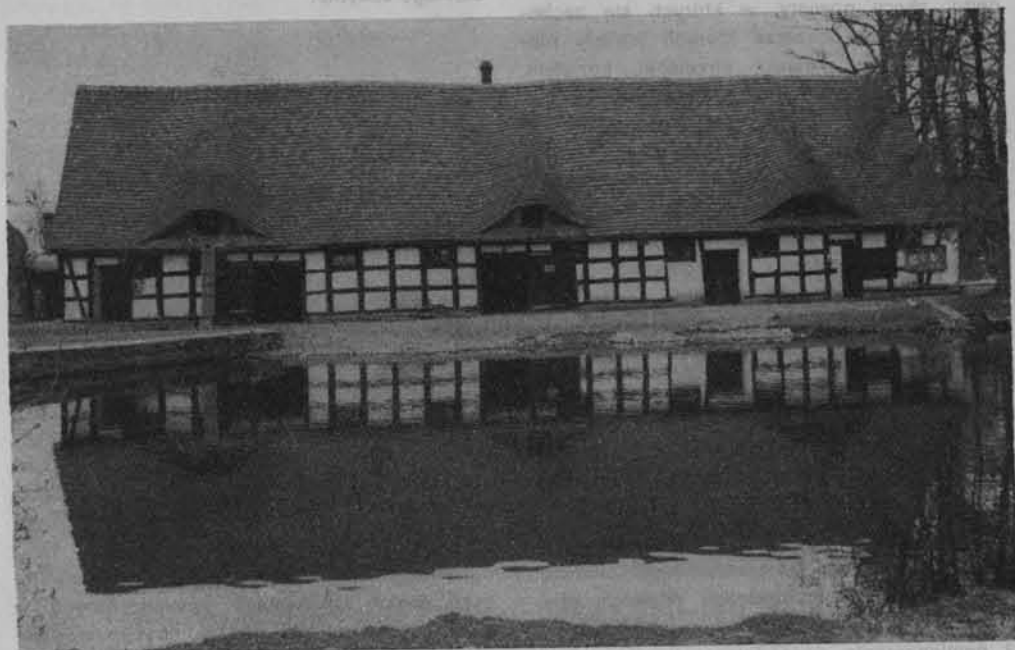
Fot. 7. Malownicza stajnia z XVIII w. w Woskwichach Małych (pow. Namysłów). Zabytkowi temu wiele uroku dodają półkoliste okienka, tzw. powieki umieszczone w dachu. Przykład konstrukcji szkieletowej, wypełnionej ceglą i później otynkowanej.
