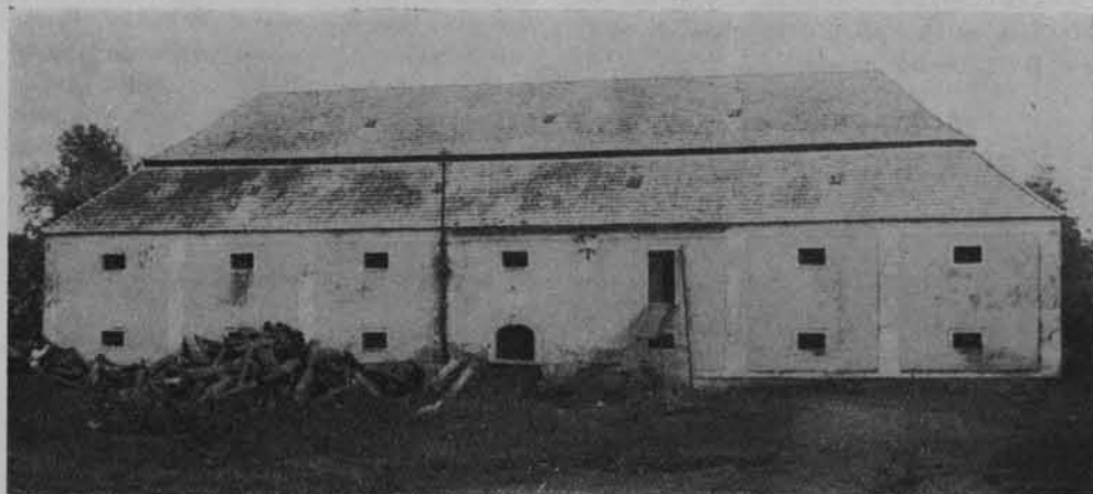
Fot. 13. Na Śląsku Opolskim mamy rodzimą formę tzw. polskiego dachu łamanego, w którym kąt nachylenia górnej i dolnej połaci jest ten sam. Jako przykład może tu posłużyć dach spichlerza w Prószkowie (pow. Opole) z XVIII w.
