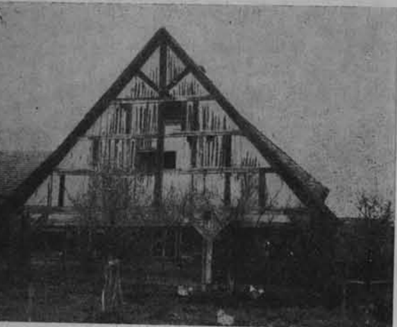
Łukawy — szczyt domu przysłupowego. Trzy słupy konstrukcji umieszczono nieregularnie, zgodnie z podziałem wnętrza o nierównej głębokości traktów.
