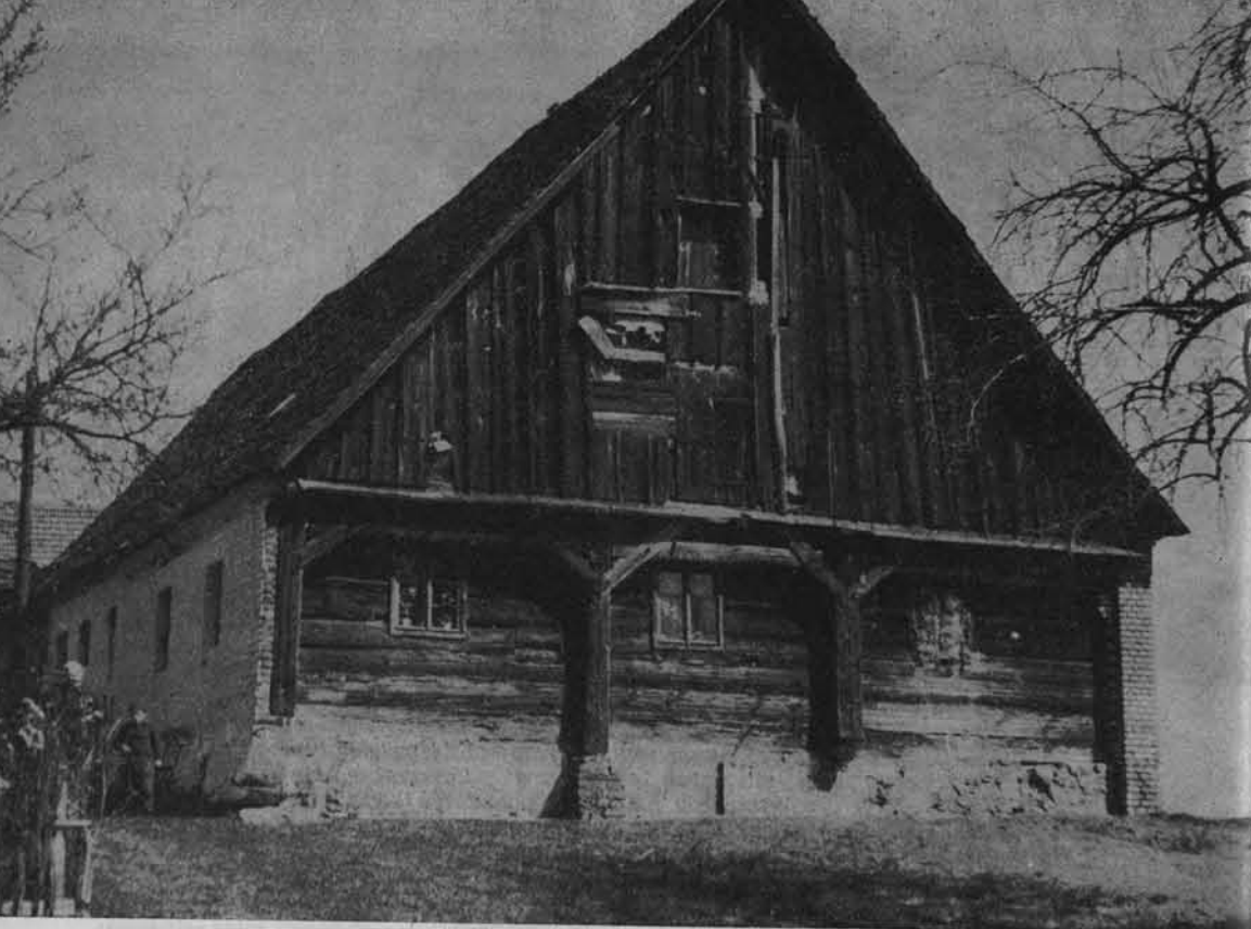
Sieniawa Żarska — dom przysłupowy. Przy krótszym boku zachowała się tu we względnie dobrym stanie konstrukcja o trzech słupach z mieczami i belką usztywniającą.
