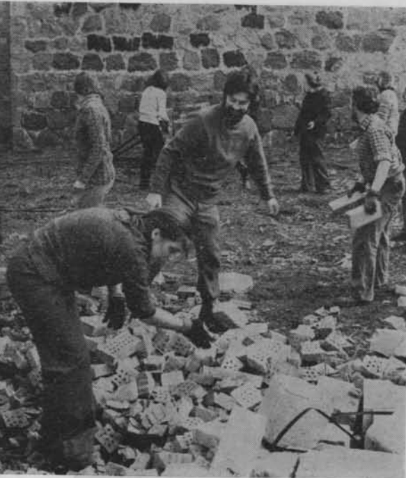
Studenci z Uniwersyteckiego Klubu Turystycznego „Unikat” w Warszawie pracują przy porządkowaniu przyszłego placu budowy w zabytkowym Tykocinie, uczestnicząc w społecznej akcji PTTK „Tykocin”, mającej na celu pomoc w rewaloryzacji tego miasteczka (fot. Stanisław Stolarczyk)
