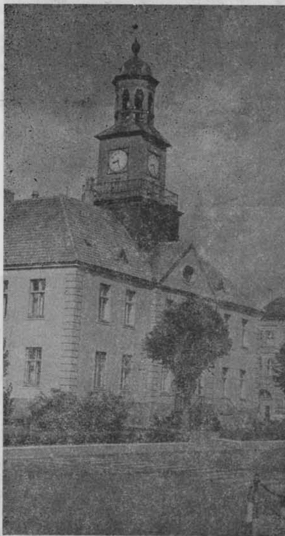
Ratusz, widok od strony południowo-wschodniej (fot. Jerzy Piotkowiak)
