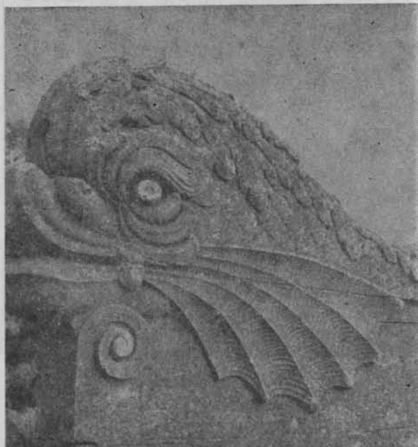
Element dekoracyjny balustrady mostu na Rędze (fot. Helena Bortnowska)
