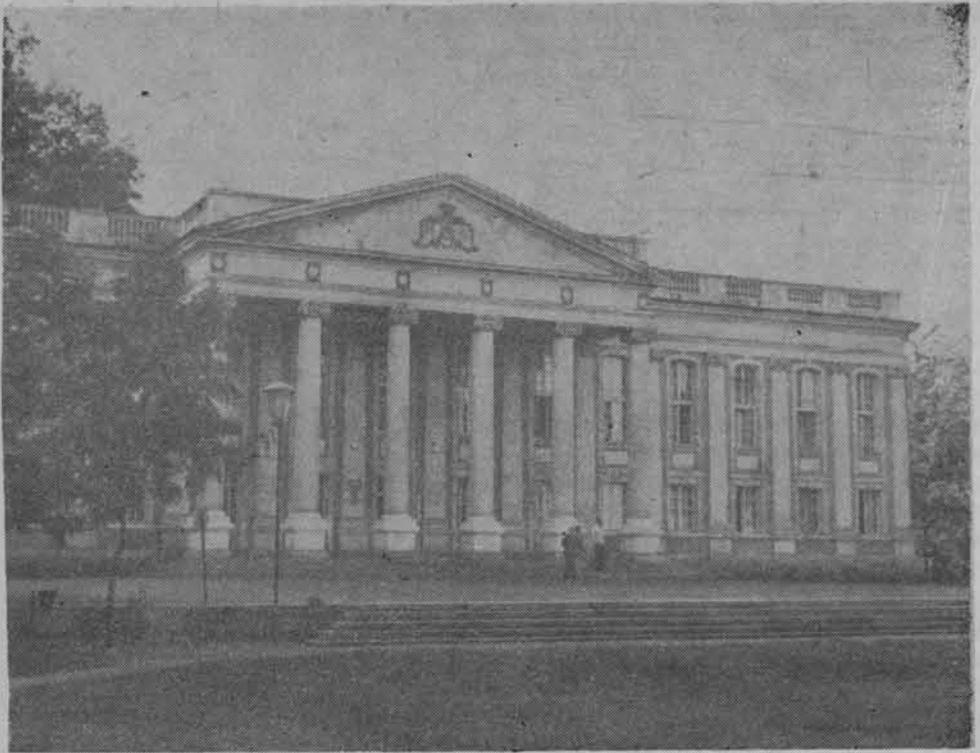
Pałac zbudowany w 1845 r., odnowiony i przebudowany w 1911, spalony w 1945. Odrestaurowany w latach 1960—1963. Obecnie Dom Turysty PTTK
