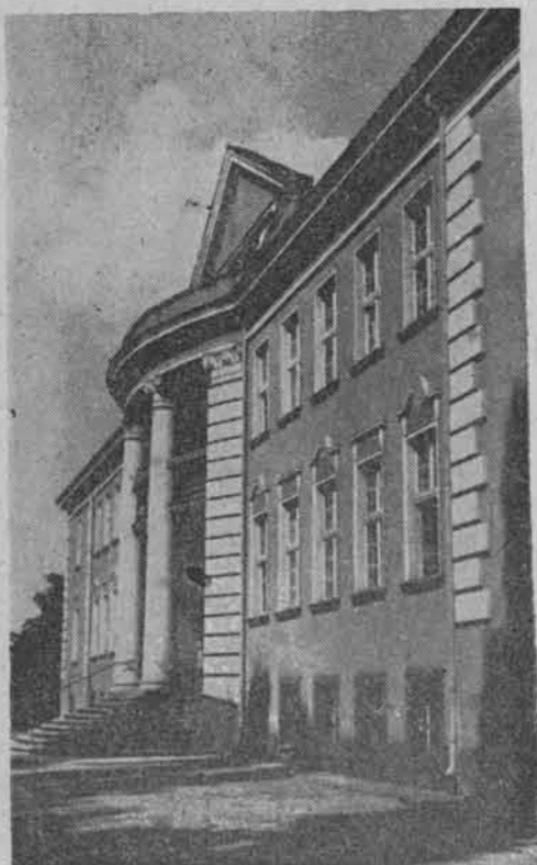
Fasada budynku Lekarskiej Przychodni Obwodowej
