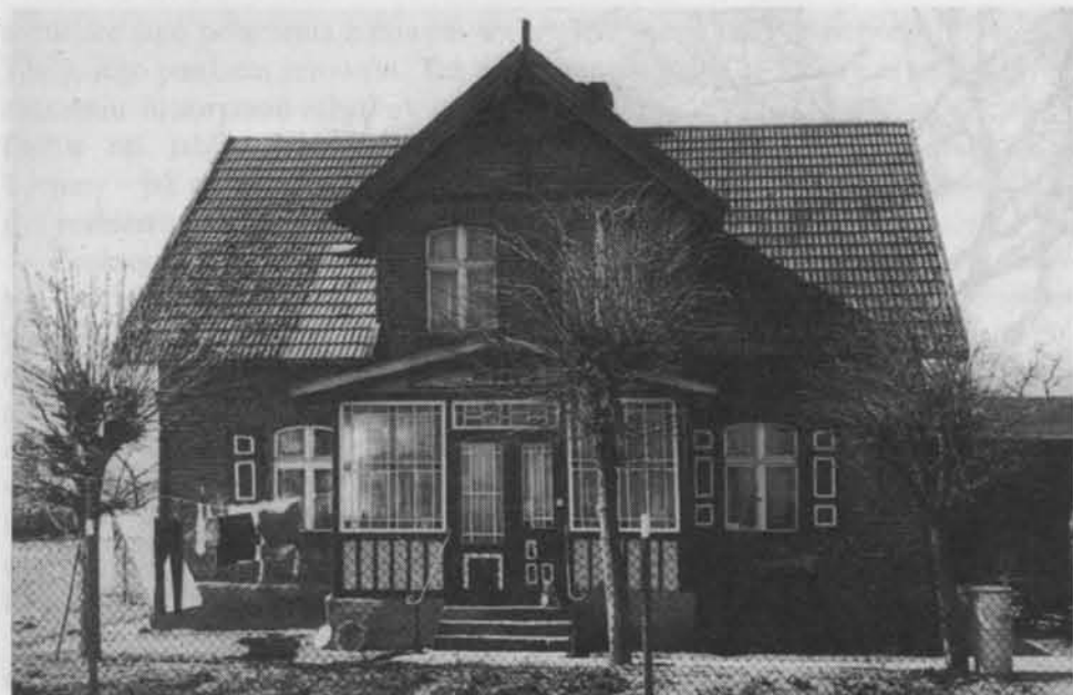
Jeden z przykładów zabytkowego budownictwa murowanego na najwyższym polskim terpie w Świbnie (na lewym brzegu Przekopu Wisły doskonale widoczny z prawego brzegu)
