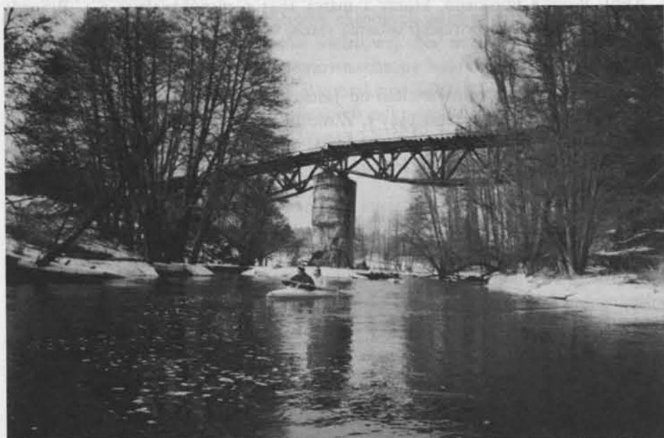
Zniszczony podczas bitwy o Wał Pomorski wiadukt na linii kolejowej Wałcz-Złotów
