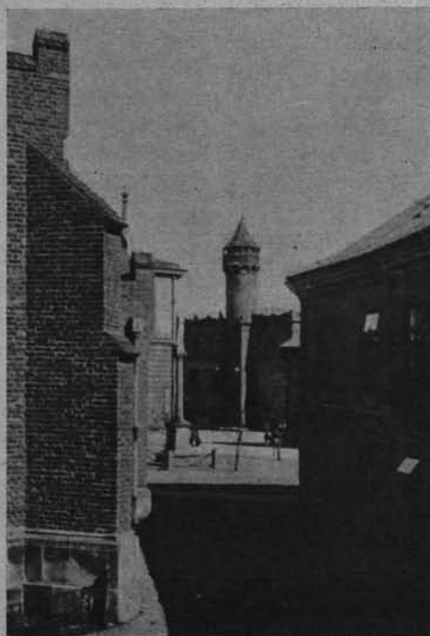
Ryc. 1. Tarnów. Widok z przed portalu wieży katedralnej w stronę ratusza.
