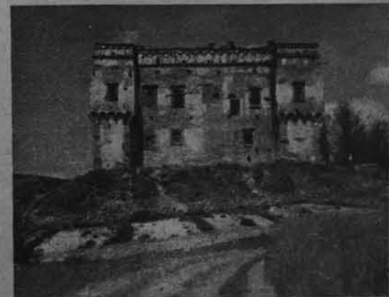
Dwór obronny w Szymbarku od strony rzeki. Na zdjęciu widoczne daleko posunięte zniszczenia.
