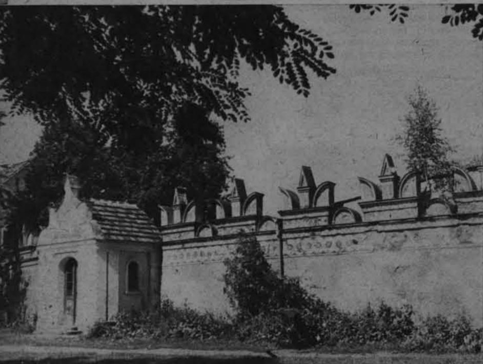
Fragment ozdobionej renesansową attyką muru obwodowego pałacu w Trzebinie. Z prawej strony widoczne wyraźnie uszkodzenie dekoracji sgraffitowej.
