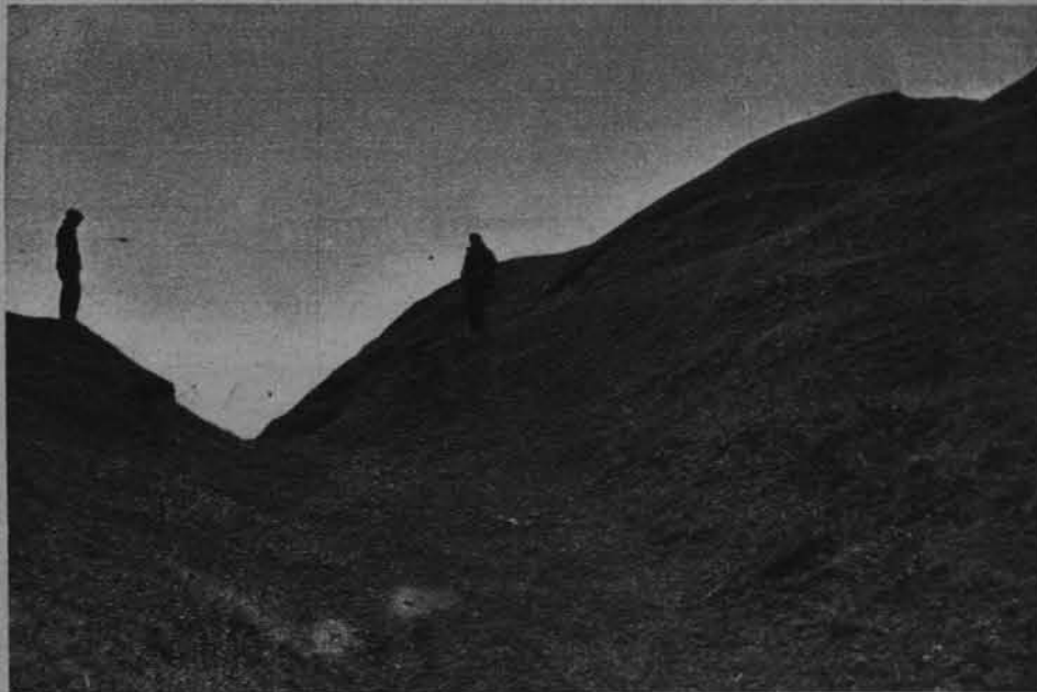
W północno-wschodniej stronie wału grodziska w Stradowie znajduje się głęboka wyrwa — niegdyś była to zapewne brama.
