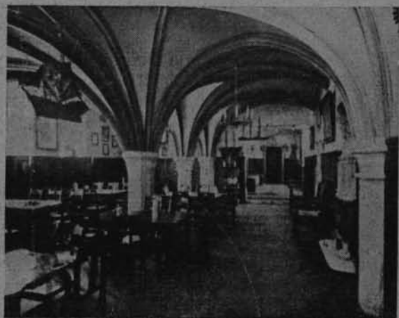
Ryc. 21. Piwnice ratusza w Kołobrzegu przerobione na restaurację.
