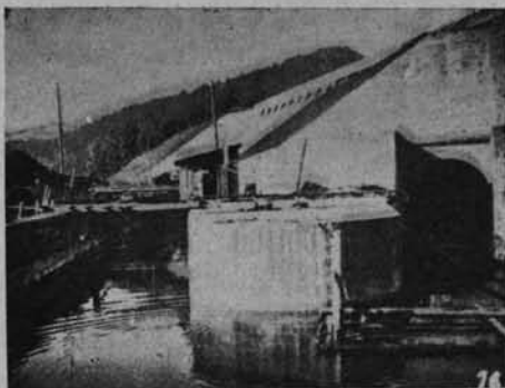
Ryc. 50. Wylot kanału odpływowego pod lewym stokiem doliny.
