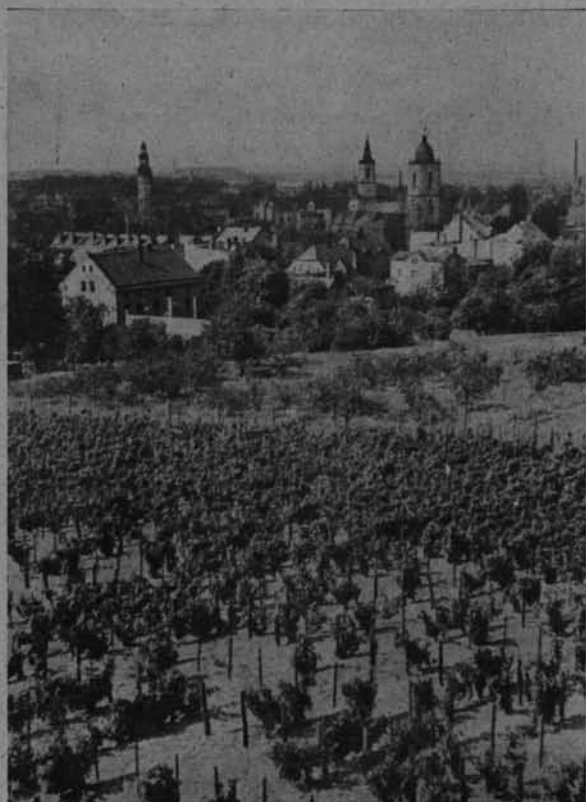
Fot. Mgr T. Dohnalik Ryc. 40. Zielona Góra. Widok na miasto z wieży miejskiej winnicy.
