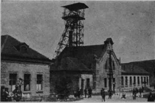
Ryc. 50. Szyb Sutoris, zbudowany za rządów austriackich. Fot. Gorgulowa.
