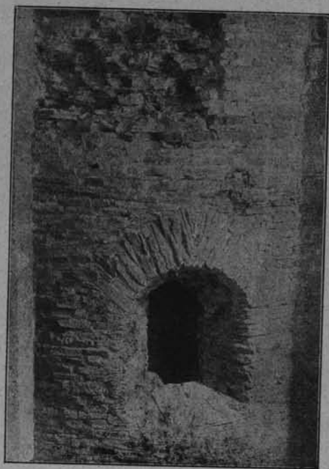
Ryc. 61. FRAGMENT ZEWNĘTRZNEGO MURU POŁUDNIOWO-WSCHODNIEJ ABSYDY WRAZ Z OKNEM.
