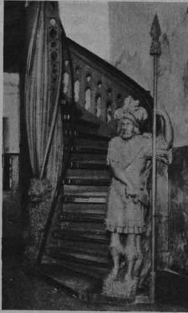
Ryc. 117. Klatka schodowa domu na ul. Mostowej. Kon. XVII w.
