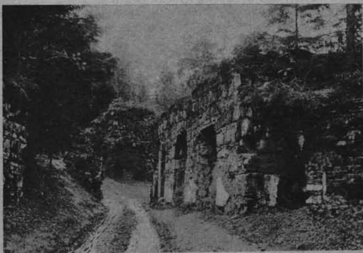
Ryc. 52. Skit Maniawski. Fot. W. Fischer. Zabudowania refektarza i brama wyjazdowa z podwórze.
