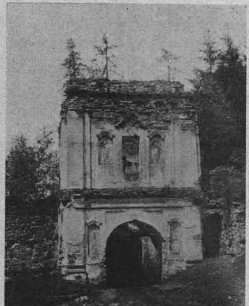
Ryc. 50. Skit Maniawski. Fot. W. Fischer. Główna brama wjazdowa, zarazem dzwonnica.
