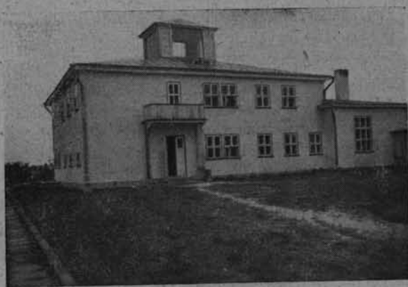
Dom turystyczny P. T. K. nad jez. Wigry (pow. Suwałki).
