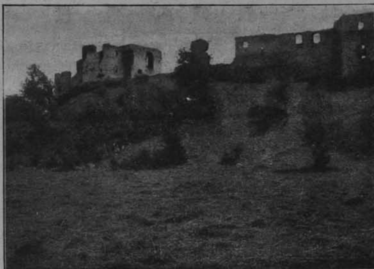
Ryc. 130. OGÓLNY WIDOK RUIN ZAMKU W PNIOWIE Fot. W. Fischer.
