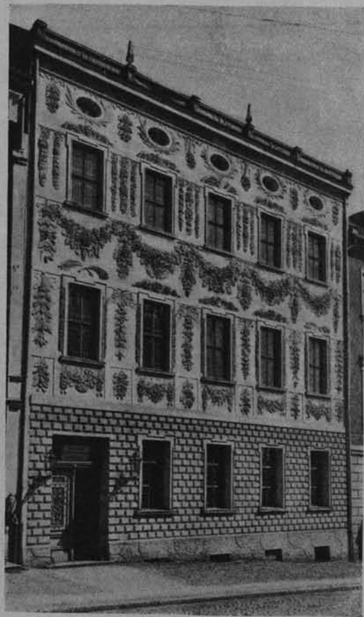
Ryc. 109. Pałac b-pa kujawskiego Dąbskiego (1693), obecnie Kasyno Oficerskie przy ul. Żeglarskiej.
