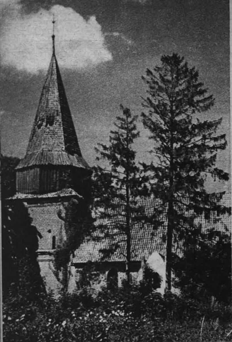
Obok: gotycka kaplica w Orłowie koło Nowego Stawu. Dziura w dachu charakterystyczna dla stanu zachowania budynku. Czy strop zdążył już przegnić? Fot. T. Chrzanowski. Poniżej: kościół w Lubieszewie, zbudowany około roku 1400. Wieża natomiast pochodzi z roku 1573. Widoczny na zdjęciu stan konserwacji zabytku wywołuje podobne pytanie jak przy zdjęciu poprzednim. Fot. Tadeusz Chrzanowski. U dołu: wieś żuławska Kończewice. Na tylnym planie widoczna drewniana wieża zabytkowego kościoła. Fot. Jerzy Tukałło
