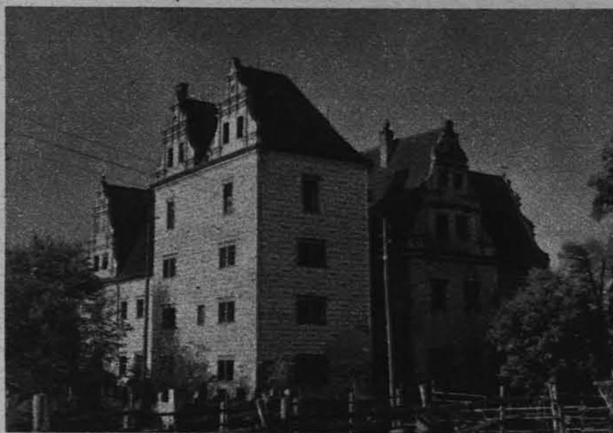
Renesansowy pałac z dekoracją sgraffitową w Goli koło Niemczy. I tu dach, z którego rozkradziono wiązanie, grozi lada chwila zawaleniem.
