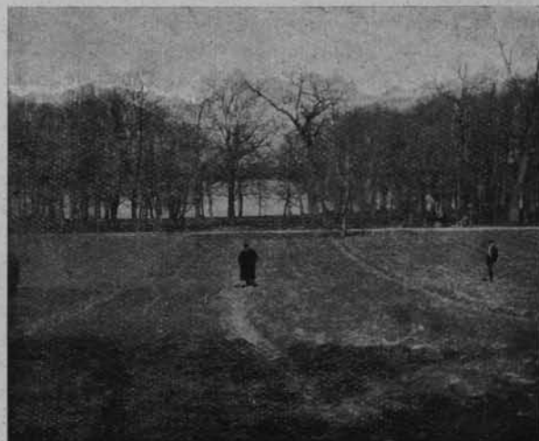
Ryc. 177. Miejsce budowy schroniska nad Świtezią w dniu 15/V 1927 r. po rogach przyszłego budynku pp. Frydrych, Bogulewicz i Frysendorf.
