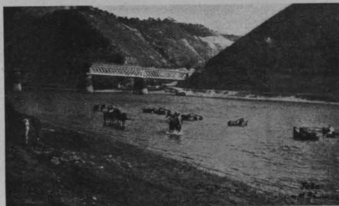
Ryc. 186. MOST ŁĄCZĄCY ZALESZCZYKI Z RUMUNJĄ.
