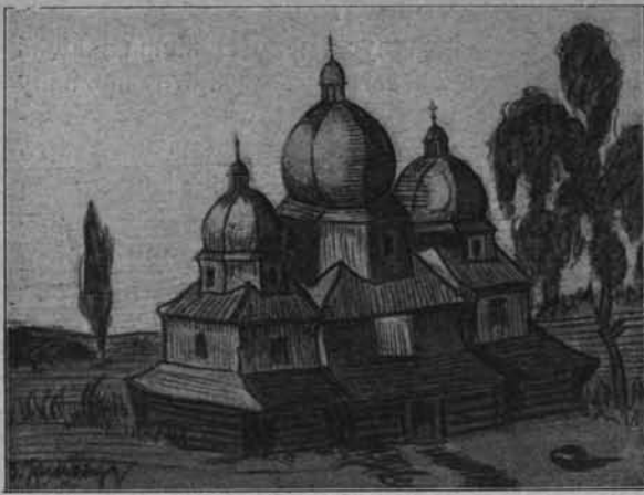
KRASNOPUSZCZA KOŁO BRZEŻAN SPALONA CERKIEW DREWNIANA. fot. B. Janusz.
